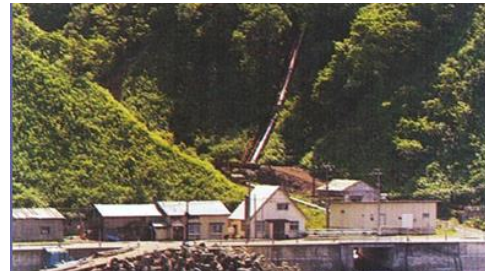
利尻島の鴛泊発電所(水力)
