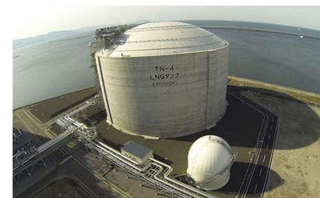
当社石狩LNG基地No.4タンク (国内最大級の地上式LNGタンク)
