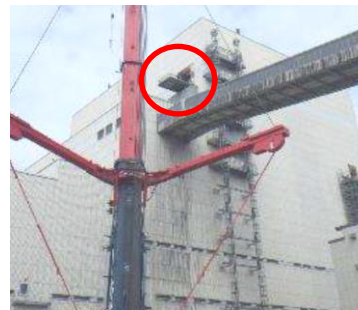
機器搬入用の開口部を設置
