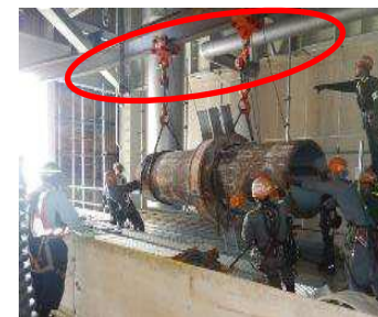
モノレールを設置
