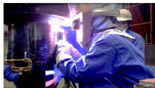
新施工法の様子
