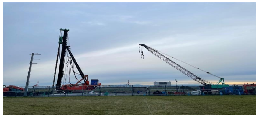
工事状況（建屋杭打ち）10月11日現在
