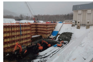
上川発電所リプレース工事の様子
