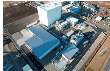
苫小牧市のバイオマス発電所
