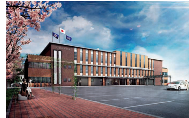
当社のZEBコンサル事例 (美幌町役場新庁舎：2021年2月竣工)
