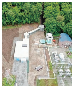
営業運転を開始した新得発電所
