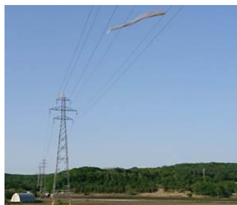
図2 送電線に飛来した農業用資材
