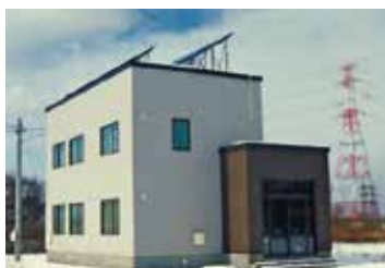
スマートエネルギー実験住宅 Smart Energy Model House
