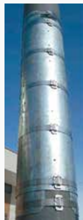
コンクリート柱補強板
