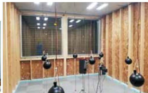
天井放射空調実験室 Radiant Air-condition Room
