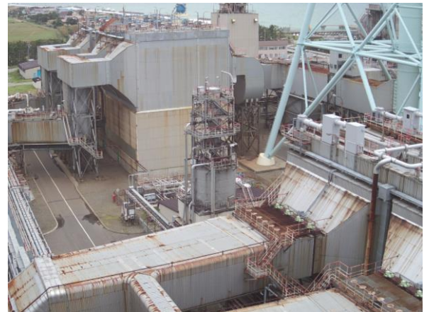
図—1 屋外点検用ドローンからの光学画像
