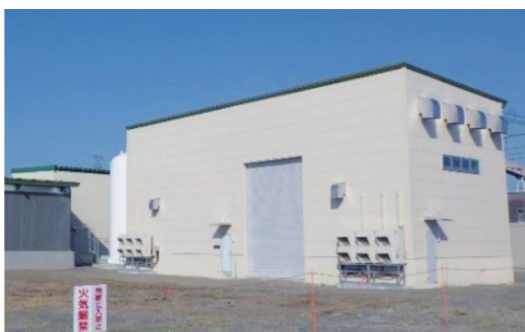
水電解装置建屋
