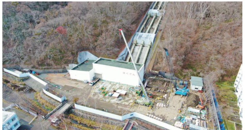
藻岩発電所建設工事の様子
