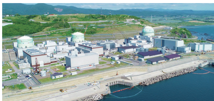
泊発電所(1号機、2号機、3号機)
