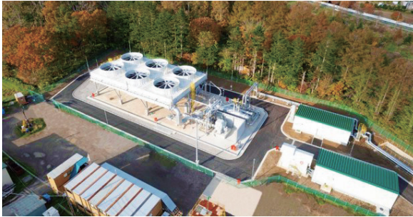
森町の地熱バイナリー発電所 (2023年11月運転開始)
