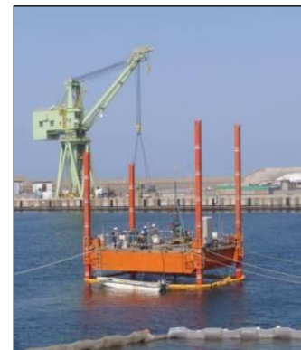
ボーリング調査（海域）
