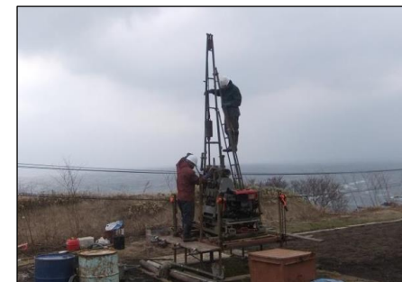
ボーリング調査（陸域）
