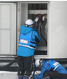
⑤可搬型代替電源車を用いた給電訓練
