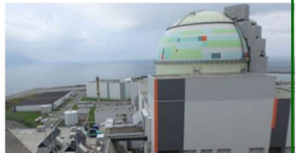
3号炉北東法面
