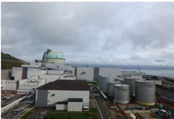
2号炉タービン建屋屋上
