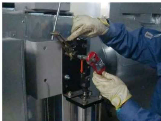
(空気作動ダンパ閉作業イメージ)
