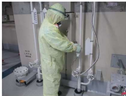
(制御用空気供給弁閉操作イメージ)
