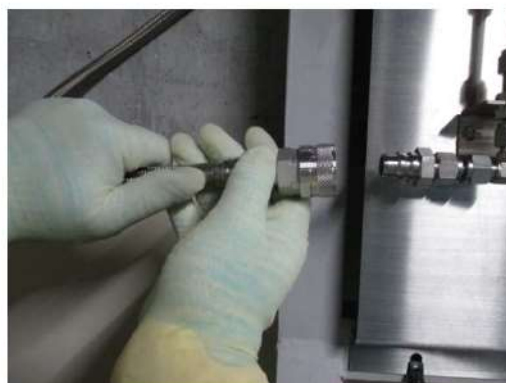
アニュラス全量排気弁操作用可搬型 窒素ガスボンベのカップラ接続 (原子炉補助建屋 T.P. 40. 3m)
