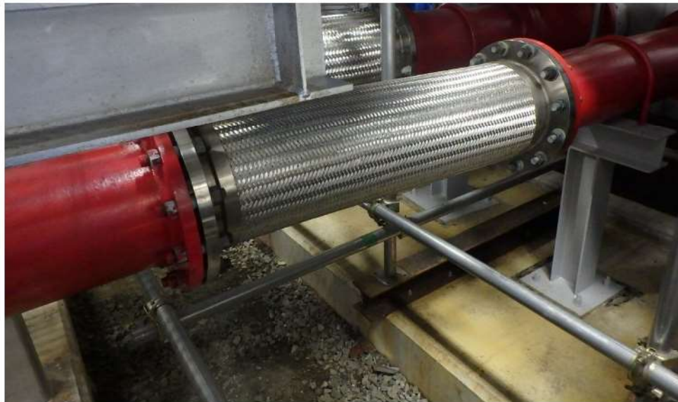
第 41-1-23 図 地盤変位対策の実施例
