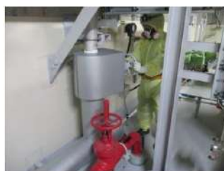
可搬型大型送水ポンプ車による原子炉 格納容器内へのスプレイ系統構成 （運転員（現場）B） （原子炉補助建屋 T. P. 10. 3m）
