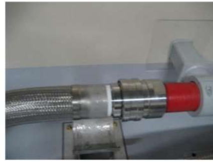
消火水系配管と格納容器スプレイ系配 管との接続のための可搬型ホース接続 後
