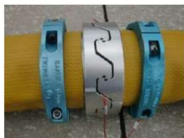
可搬型ホース (150 A) 接続後
