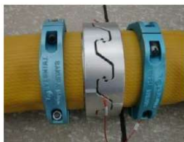
可搬型ホース (150 A) 接続後
