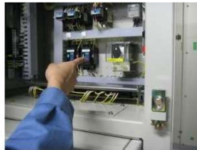
代替非常用発電機受電遮断器操作 (安全補機開閉器室) (原子炉補助建屋T. P. 10. 3m)
