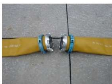
可搬型ホース(150A)接続前
