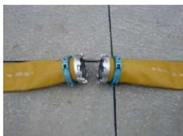
可搬型ホース(150A)接続前
