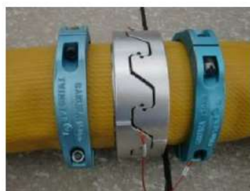
可搬型ホース(150A)接続後
