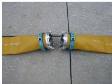
可搬型ホース（150 A）接続前
