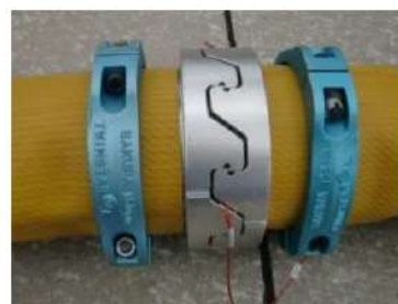
可搬型ホース(150A)接続後
