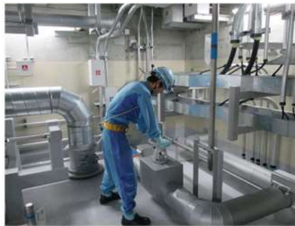
RHRS-CSS 連絡ライン系統構成 （原子炉補助建屋 T.P. 10. 3m（中間床））
