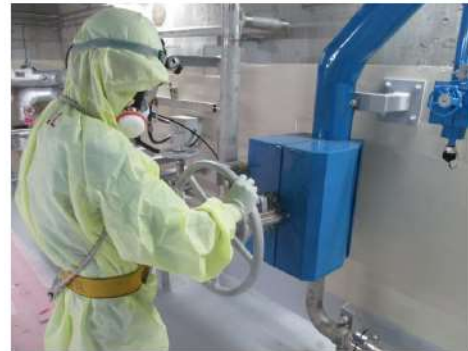
B-充てんポンプ自己冷却運転系統構成 （原子炉補助建屋 T.P. 10. 3m（中間床））
