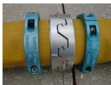
可搬型ホース(150A)接続後
