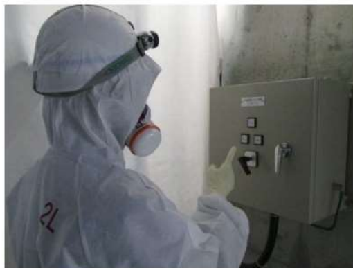
代替格納容器スプレイポンプ起動操作 (周辺補機棟 T. P. 10. 3m)
