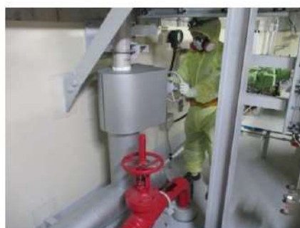
消火ポンプによる原子炉格納容器内へのスプレイ系統構成 （運転員（現場）B） （原子炉補助建屋 T.P. 10.3m）
