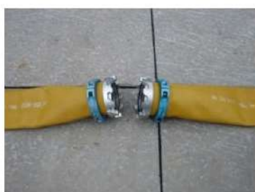
可搬型ホース(150A)接続前
