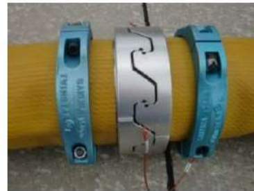
可搬型ホース（150A）接続後
