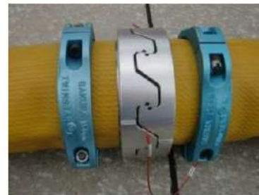
可搬型ホース（150A）接続後
