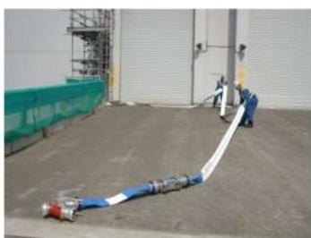
可搬型ホース敷設 (屋外)
