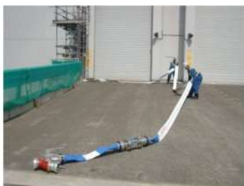
可搬型ホース敷設 (屋外)
