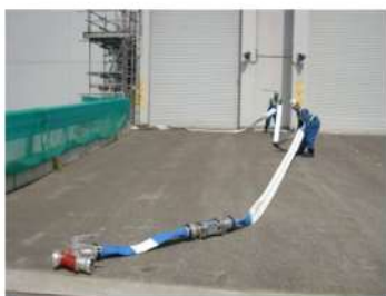
可搬型ホース敷設 (屋外)
