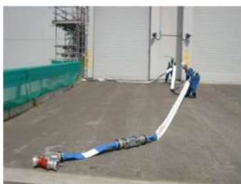
可搬型ホース敷設 (屋外)
