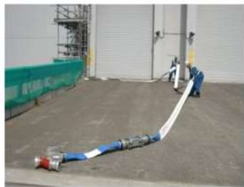
可搬型ホース敷設 （屋外）
