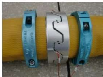
可搬型ホース(150A)接続後
