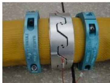
可搬型ホース(150A)接続後
