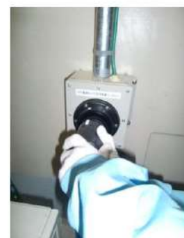
電源ケーブル接続
