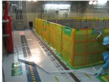
消防ホース敷設 (燃料取扱棟 T. P. 33. 1m)
