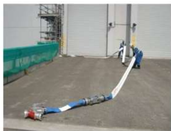
可搬型ホース敷設 （屋外）
