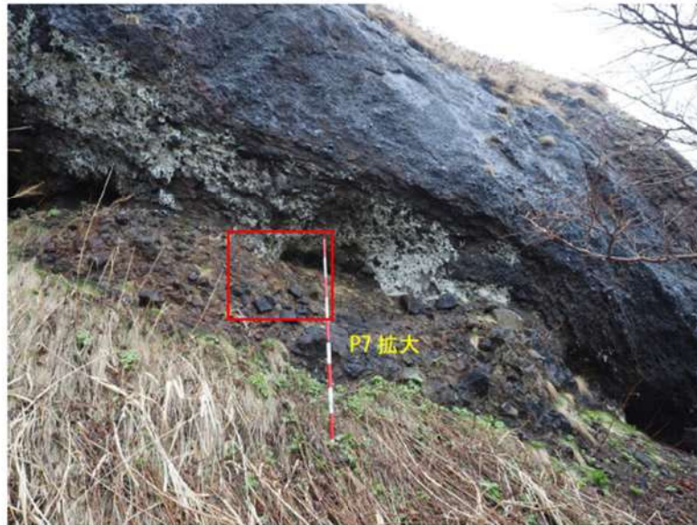
図 2.1.a.c-4 (7) 防潮堤（茶津側）露頭状況
