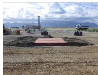
検証ヤード（復旧後）
