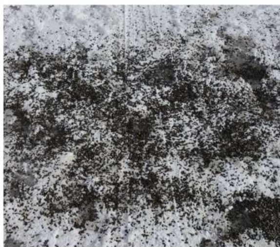
第3図 すべり止め材の散布例
