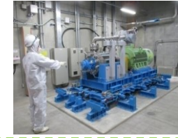
蒸気発生器直接給水用高圧ポンプ
