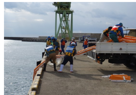
シルトフェンス設置訓練
