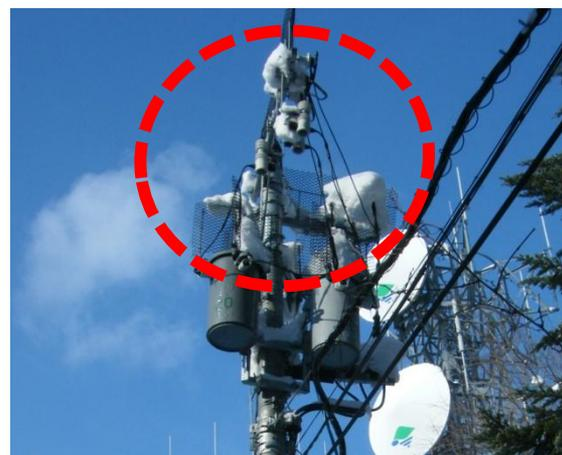
雪を分離する2種類の機材を組み合わせて設置し、冠雪は減少しました。
