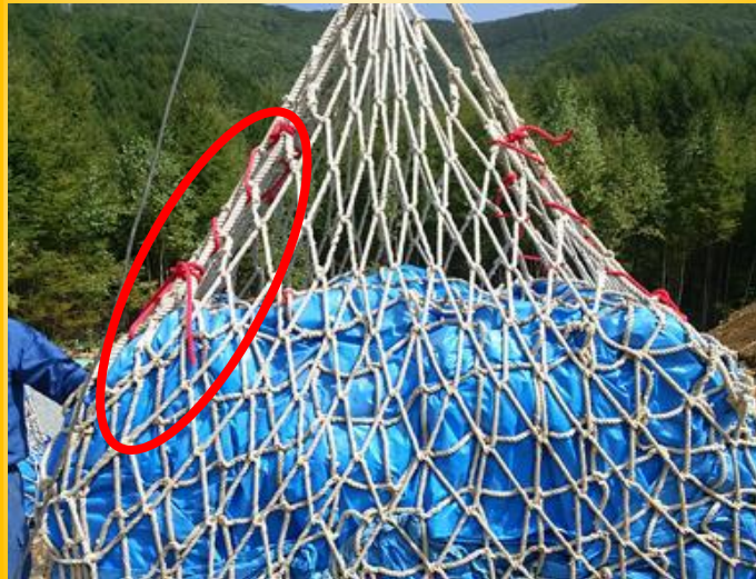
モッコの隙間の固縛状況
