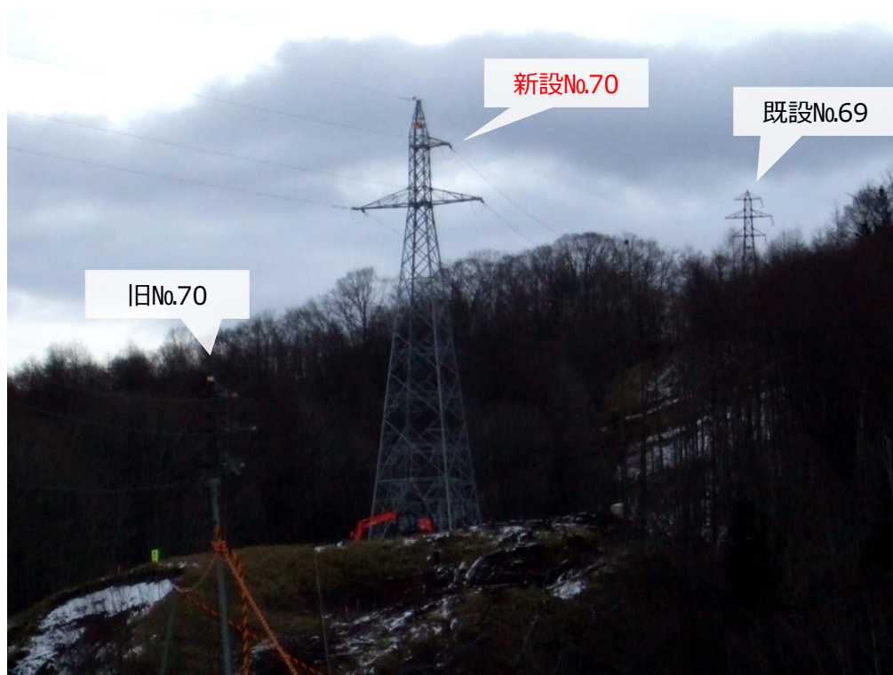
①新設No.70 鉄塔
