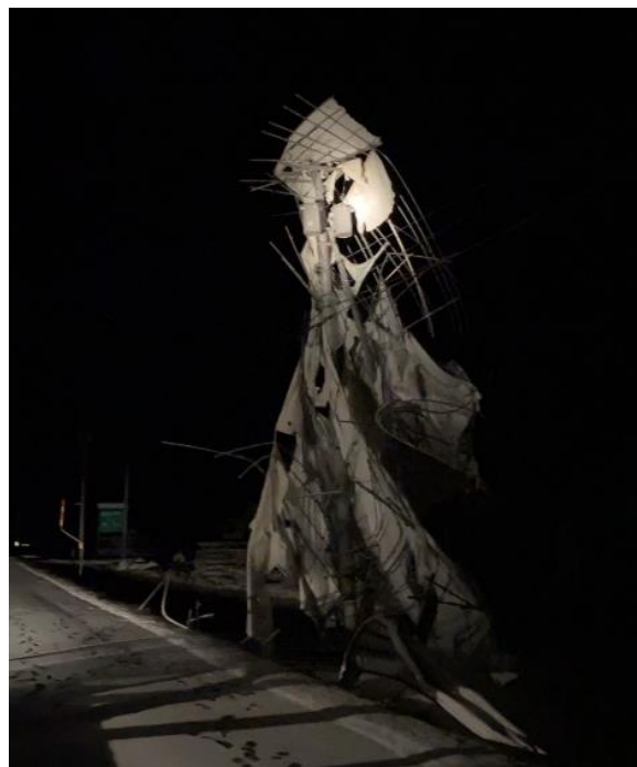
電柱に巻き付いている飛来物
