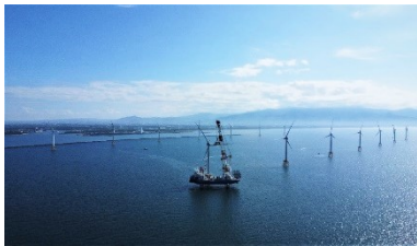
石狩湾の洋上風力発電 (2024年1月運開)
