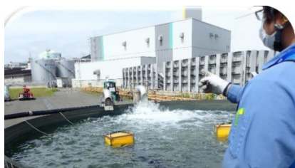
ポンプ運転操作による送水訓練
