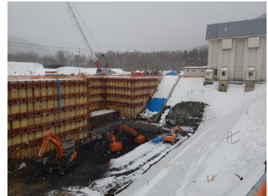
上川発電所リプレース工事の様子
