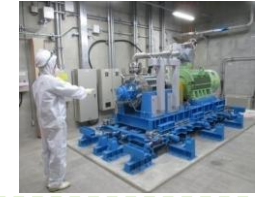
蒸気発生器直接給水用高圧ポンプ
