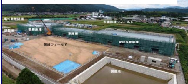
現地工事進捗状況(平成28年9月27日)
