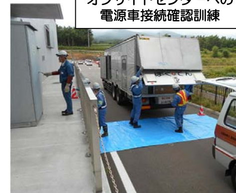
ケーブル接続（発電機車側）
