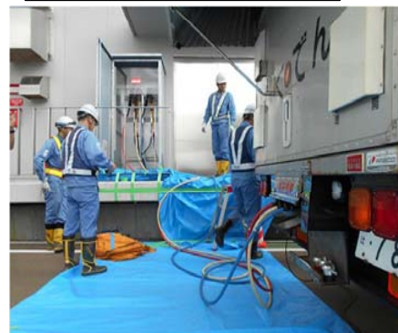
ケーブル接続（施設側）
