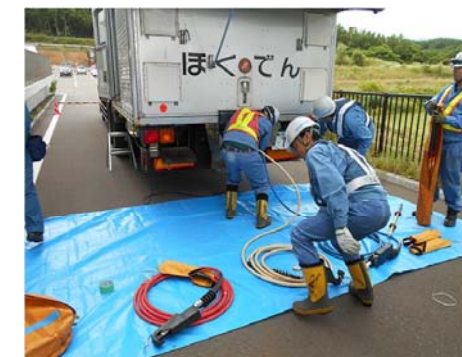
ケーブル接続（発電機車側）
