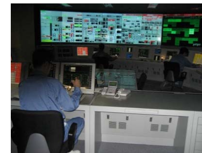
全交流動力電源喪失を想定した運転シミュレータ訓練
