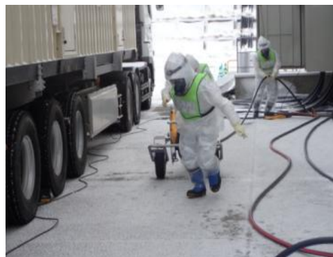
ケーブル敷設訓練
