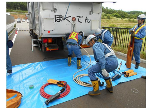
ケーブル接続（発電機車側）
