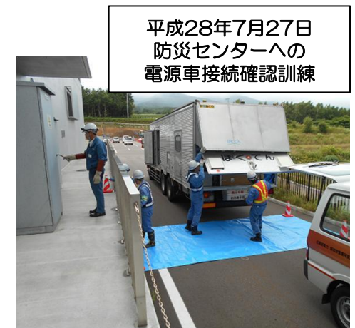
ケーブル接続（発電機車側）
