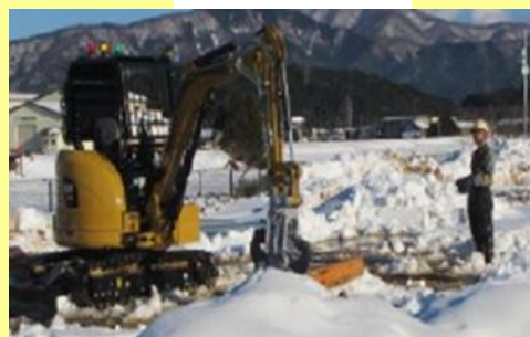
無線重機訓練
