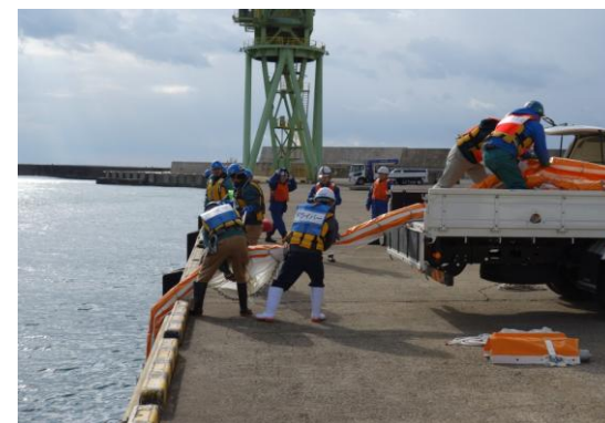
シルトフェンス設置訓練
