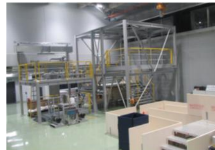
事務所棟 訓練施設
