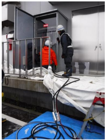
ケーブル接続作業
