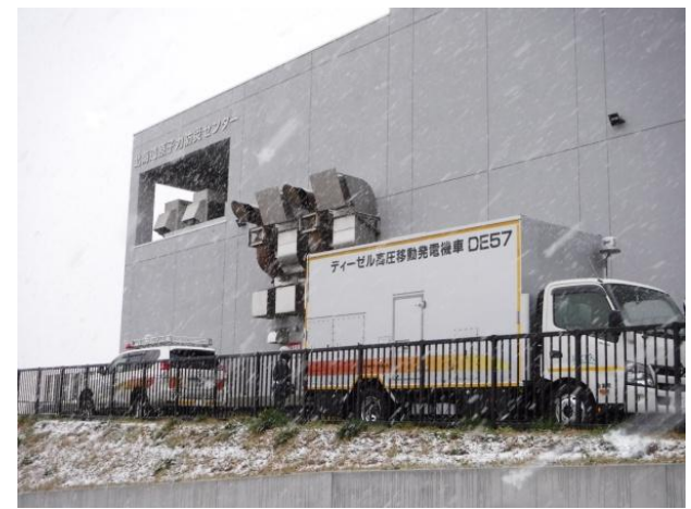
平成29年11月15日 オフサイトセンターへの 電源車接続確認訓練
