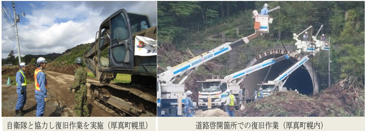
図 3.7 復旧作業の状況
