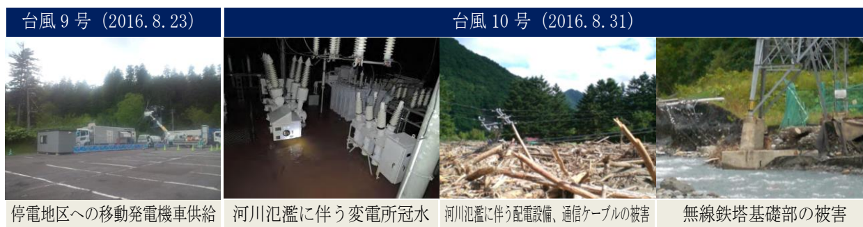
図 3.18 2016 年台風 9 号・10 号の被害状況
