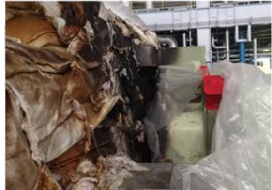
ケーシング内部の状況
