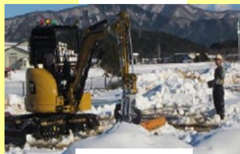
無線重機訓練
