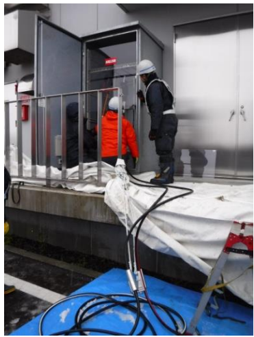
ケーブル接続作業
