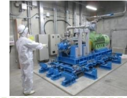
蒸気発生器直接給水用高圧ポンプ
