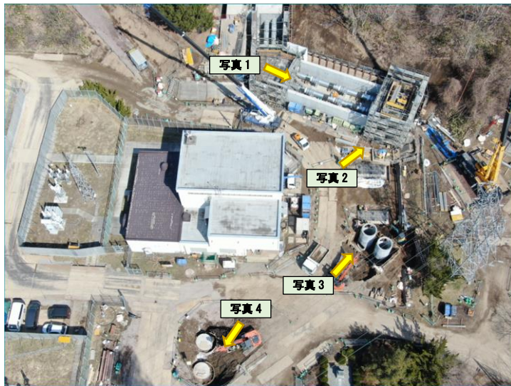
[工事箇所全景(2024年4月2日撮影)]
