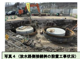
写真4(放水路側接続柵の設置工事状況)
