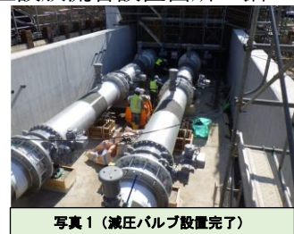
写真1(減圧バルブ設置完了)
