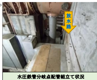
水圧鉄管分岐点配管組立て状況
