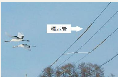
標示管を設置した電線の脇を飛ぶタンチョウ
